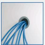
Passage de cuve diamètre 30 mm pour caractérisation et qualification sur site. Positionné sur le côté droit à 1/3 du haut (dans chaque compartiment).
