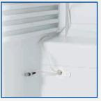
Passage cuve Ø 15 mm pour sonde GTC - PT100 ou numérique (dans chaque compartiment).
