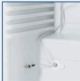
Passage cuve  $\varnothing 15$  mm pour sonde GTC - PT100 ou numérique.
